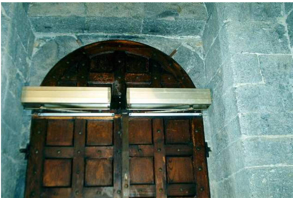
Pogonski mehanizam zakretnih automatskih vrata.
